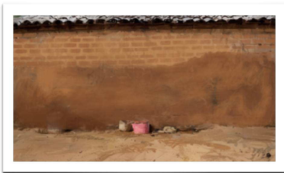
Figura 13. Muro de adobe con fragmento de aplanado de tierra. Ilustración elaborada por Yamila Garibay.
