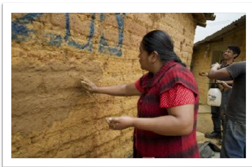
Figura 6. Fotografía de una mujer mazateca rellenando una grieta durante un taller (Fotografía de Carlos Cruz, 2023).
