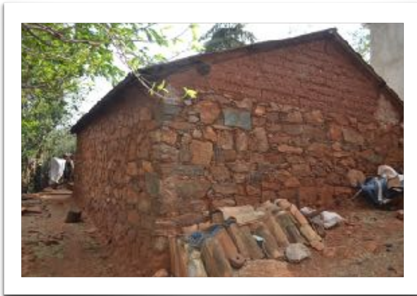
Figura 8. Muro de piedra en San Pedro; al frente las tejas recuperadas del techo antiguo, ahora de lámina. Fotografía de Annick Daneels (trabajo de campo, 2024).
